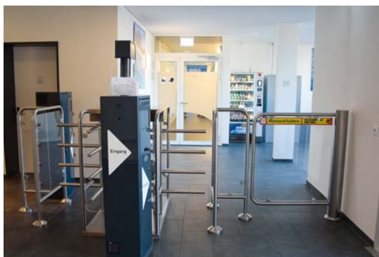
Zutritt zu den Garderoben und zur Schwimmhalle.
