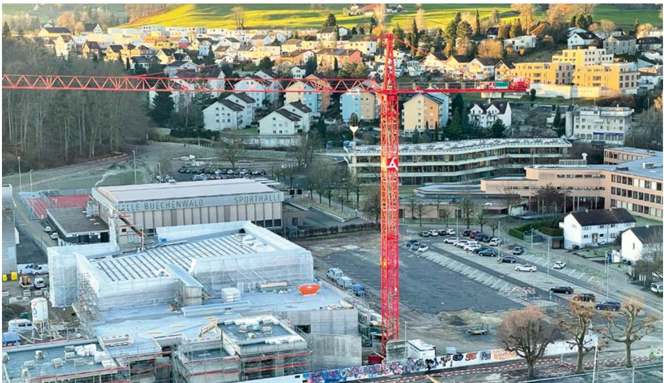
Modul 1 Sportwelt-Baustelle, ohne Fussballareale, am 22. 12. 2025.
