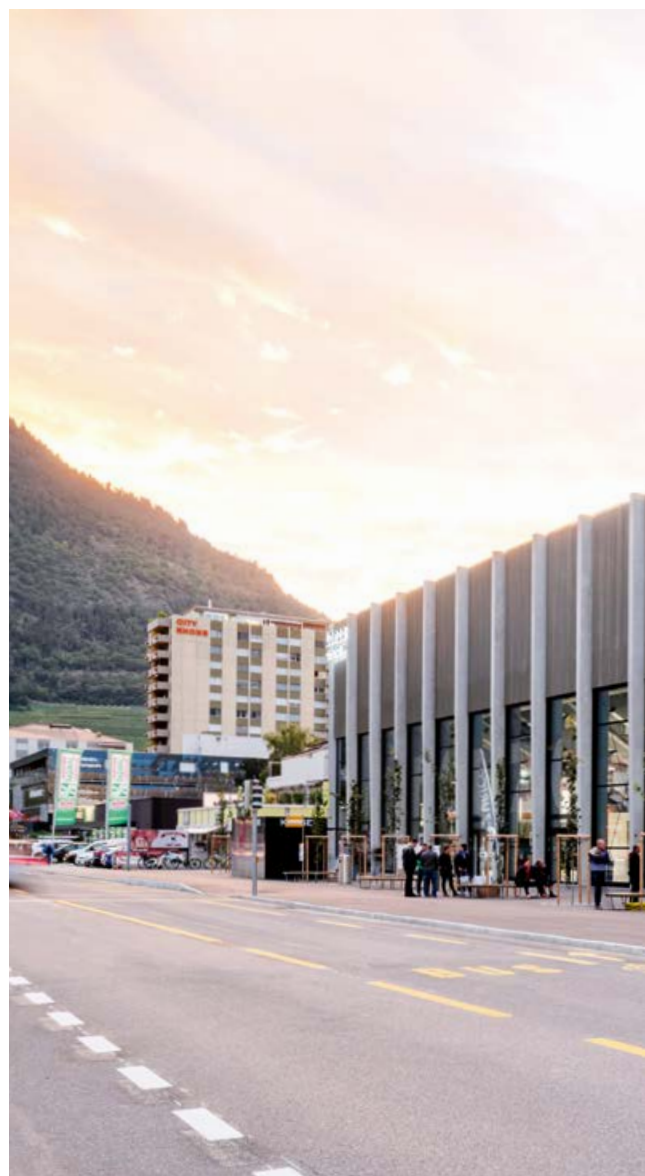
Die Glasfassade der Lonza Arena zur Kantonsstrasse hin.
