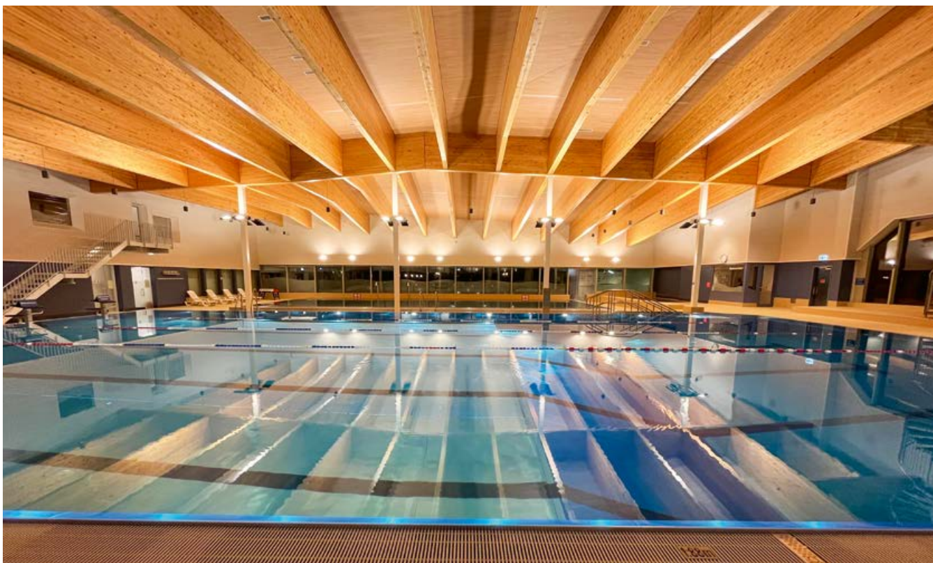
Die neue Holzdachkonstruktion ist ein Blickfang.
