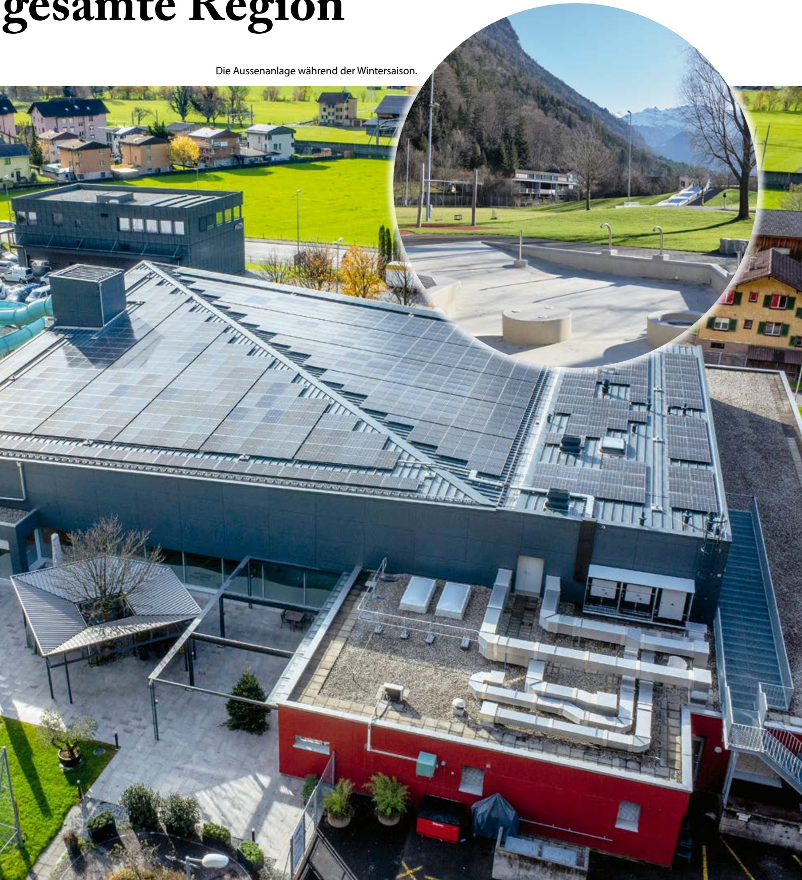
Das Schwimmbad Altdorf mit leistungsstarker PV-Anlage auf dem neuen Schrägdach.
