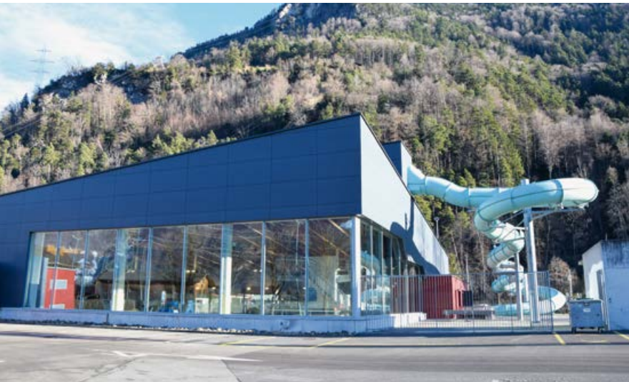
Das Hallenbad mit neuer hinterlüfteter Fassade und Röhrenrutsche.
