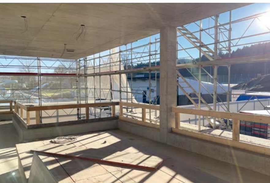
Blick aus dem Zugangsbereich beider Bäder ins Freie.
