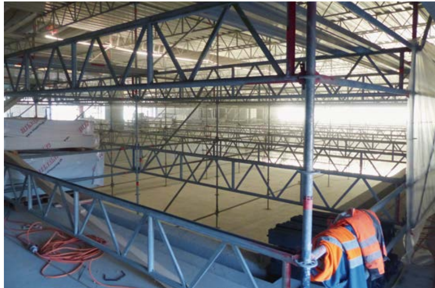
Eingerüstet für den Innenausbau: das Hauptbecken.
