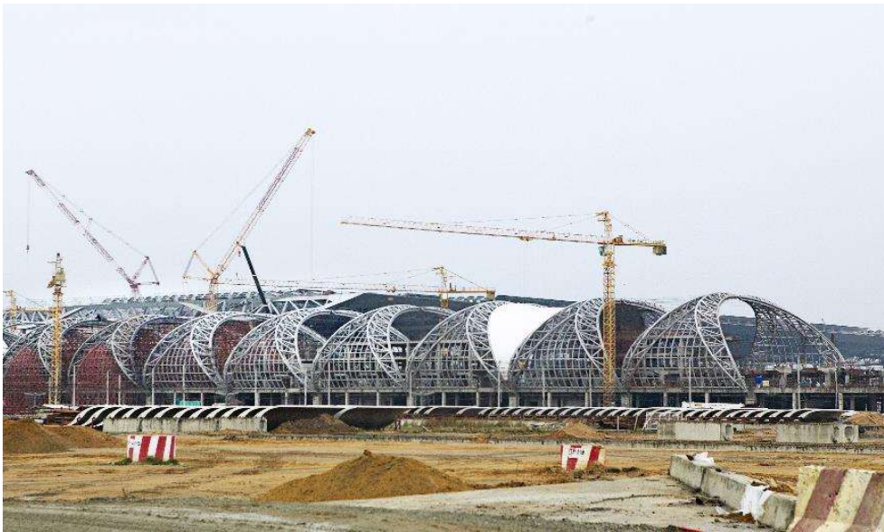
2004 Flughafen Bangkok | Erstes Grossprojekt: Lieferung von Drahtseilen für die Membrandachkonstruktion
