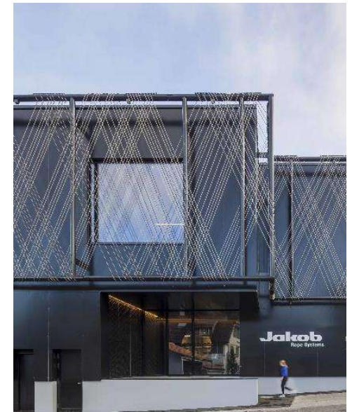
2019 | 2022 Neubau und Ausbau Hauptgebäude in Trubschachen
